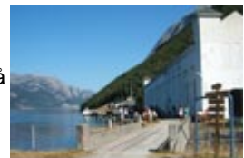
Kraftstasjonen på Flørli Foto: Hanne Sundbø
